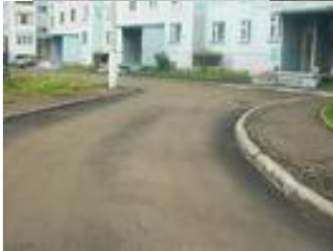
Установка урн. Установка скамеек. Обеспечение освещения дворовых территорий. Ремонт дворовых проездов
